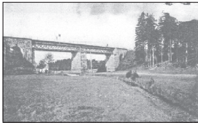
Železniční most přes hraniční potok (km 35,8).
